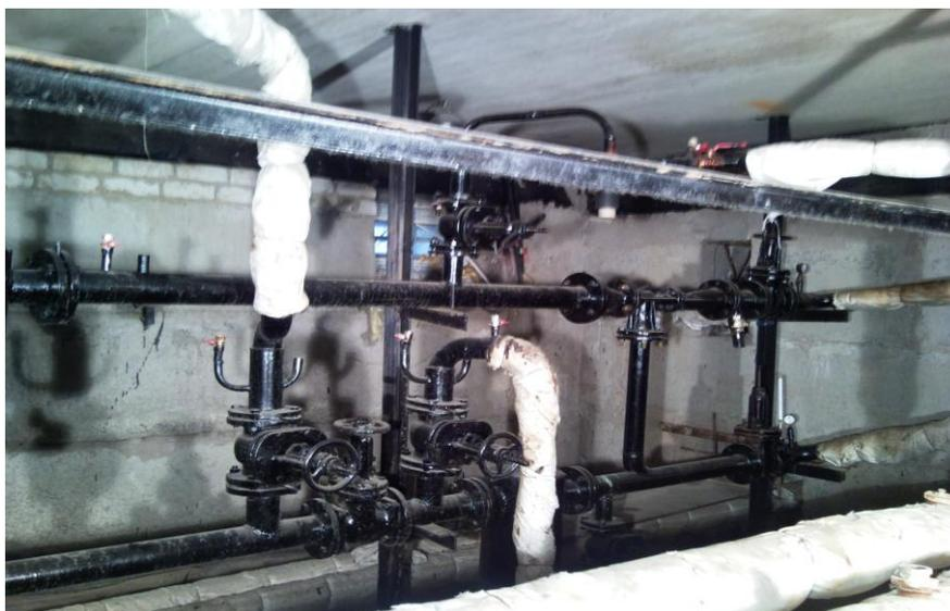
*Фото. Тепловой пункт в подвале дома – обеспечивает нас теплом и горячей водой*
